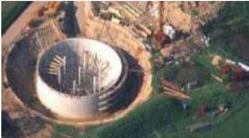
Abbildung 2: Langzeitwärmespeicher der ersten Generation in Hamburg Bramfeld
