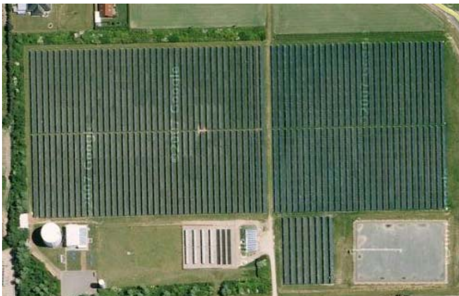
Abbildung 3: Kollektorfeld und Langzeitwärmespeicher (rechts unten) im dänischen Marstal
